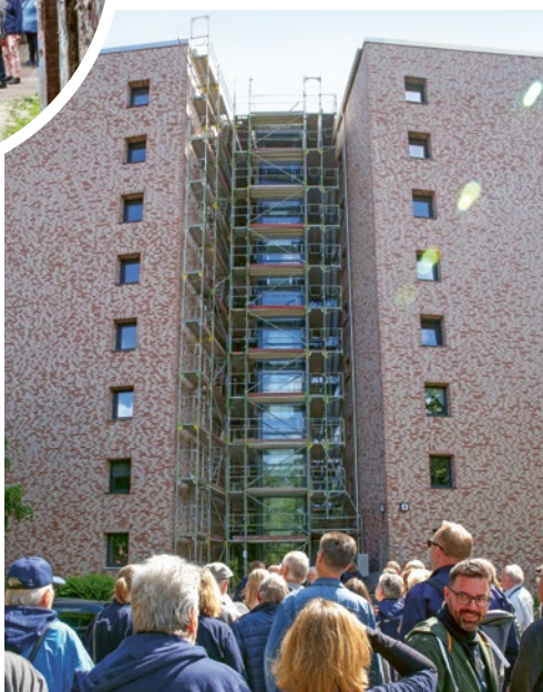
In der Friedrichshainstraße 8 machten sich die Teilnehmenden ein Bild von der energetischen Modernisierung.
